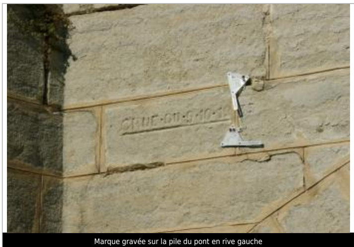
Marque gravée sur la pile du pont en rive gauche
