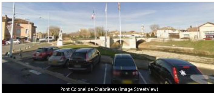
Pont Colonel de Chabrières (image StreetView)
