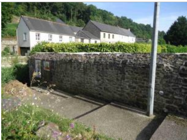
Repère de crue 2014 rue de Clisson - Source : SMAP, juin 2018
