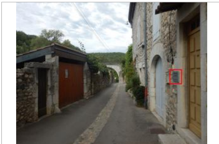
Vue du site
