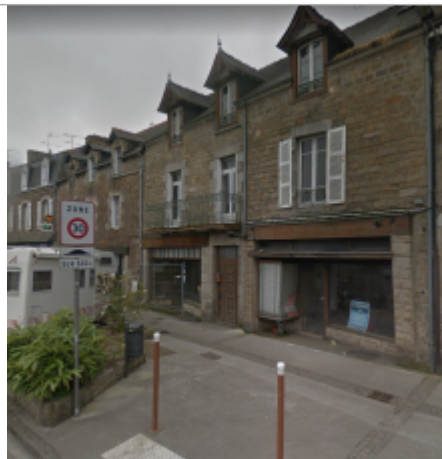
N°8-10 rue des Quais - Source : Google Maps, avril 2018
