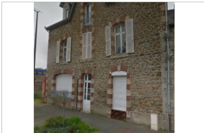
N°10 rue de Dinard (coffret EDF) - Source : Google Maps, avril 2018
