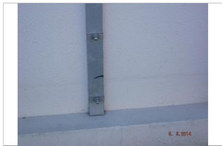
Laisse de crues reportée sur le poteau - Source : DDTM 22
