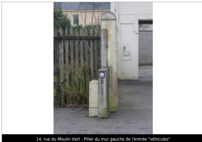
14, rue du Moulin Vert - Pilier du mur gauche de l'entrée "véhicules"
