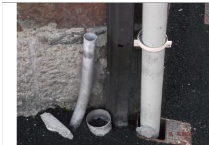
Laisse de crues sur le bâtiment, à l'angle - Source : DDTM 22
