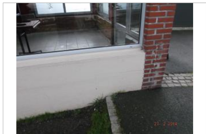
LdC muret du bar - Source : DDTM 22
