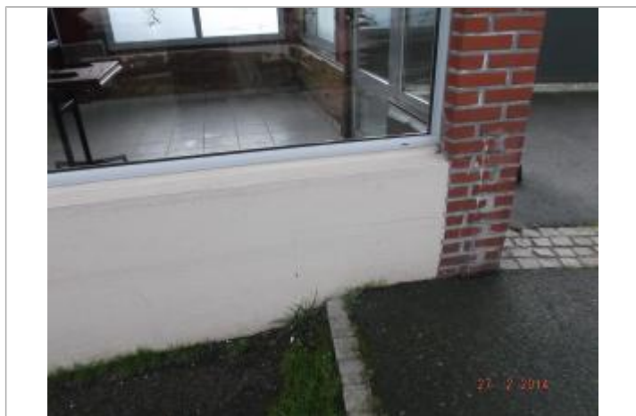
LdC muret du bar - Source : DDTM 22
