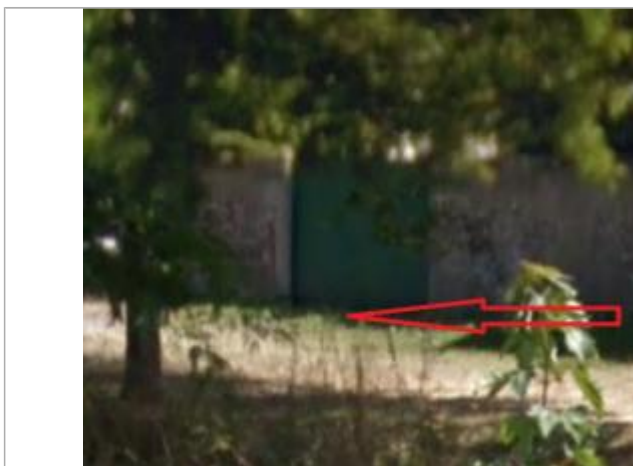
Portail vert situé à l'arrière du bâtiment du côté de l'Arguenon (quai Jacques Cartier)
