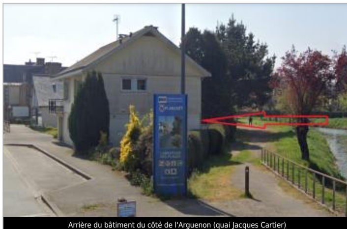
Arrière du bâtiment du côté de l'Arguenon (quai Jacques Cartier)
