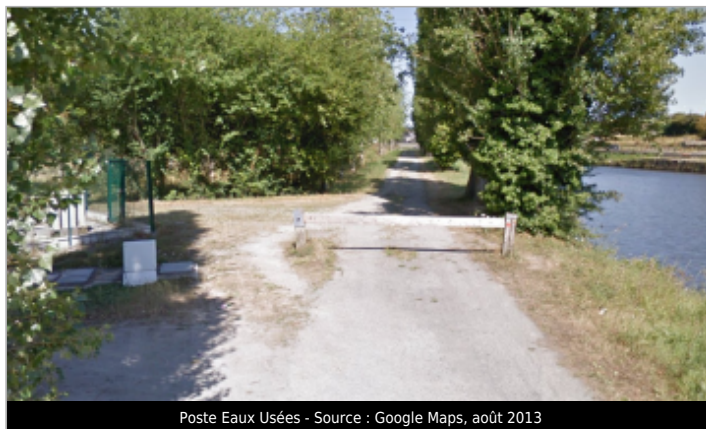
Poste Eaux Usées - Source : Google Maps, août 2013
