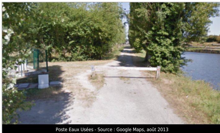
Poste Eaux Usées - Source : Google Maps, août 2013
