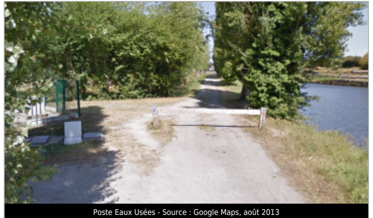
Poste Eaux Usées - Source : Google Maps, août 2013
