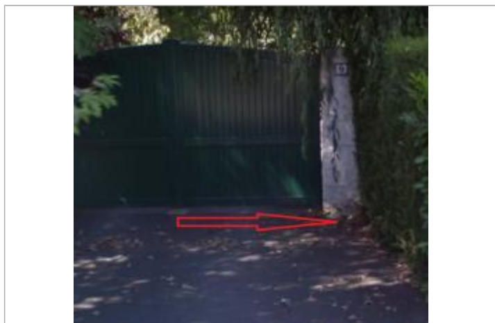
sol au pied du poteau droit du portail d'entrée
