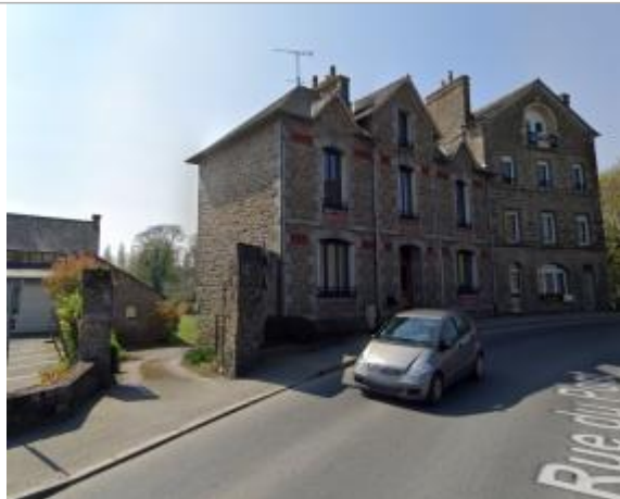
Bâtiment au 52 rue du Pont
