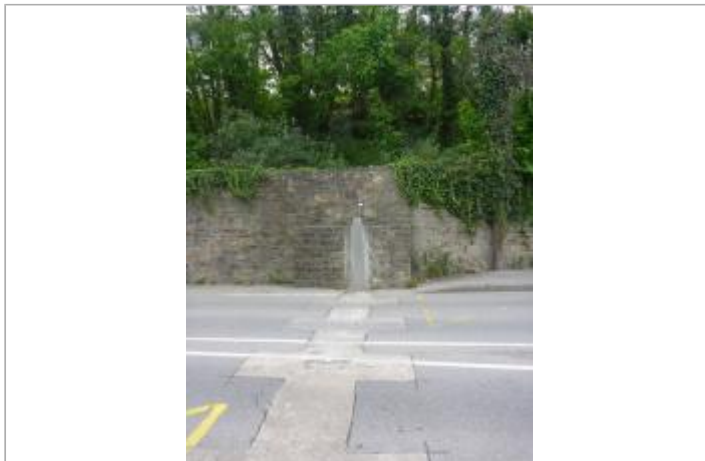
14, rue de l'Hippodrome - Batardeau
