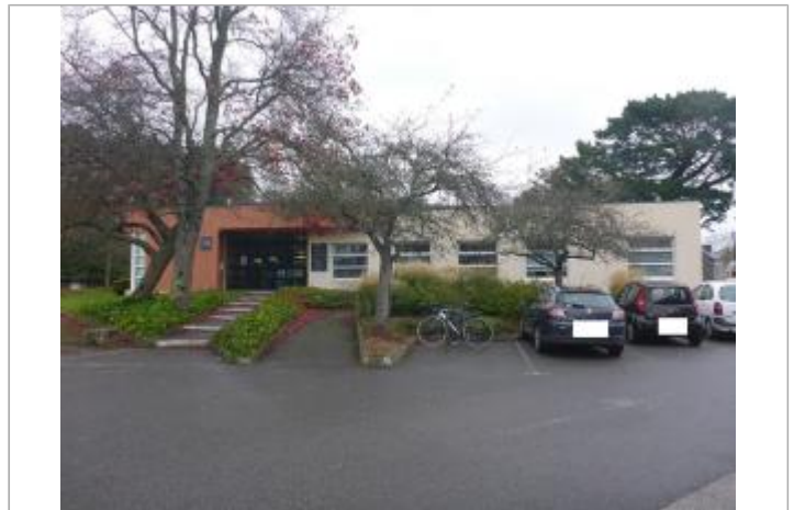
55, impasse de l'Odet - Entrée de la Maison des Associations
