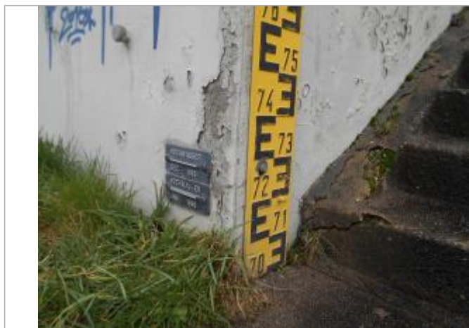
Vue du repère - Source : DREAL Grand Est/CEREMA 2018
