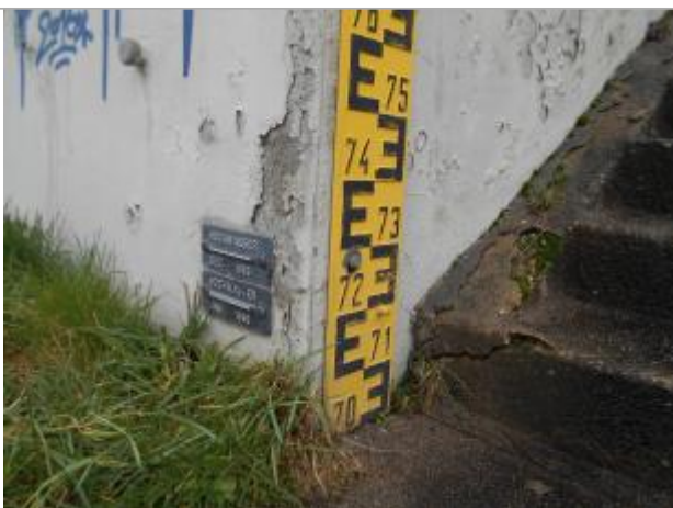
Vue du repère - Source : DREAL Grand Est/CEREMA 2018
