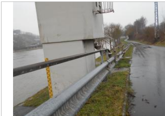
Vue du site - Source : DREAL Grand Est/CEREMA 2018
