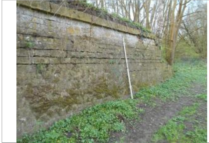
Vue du site - Source : DREAL Grand Est/CEREMA 2018
