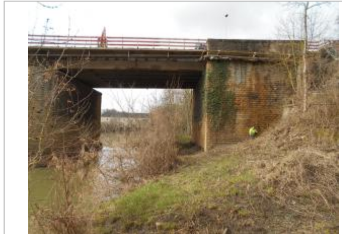
Vue du site - Source : DREAL Grand Est/CEREMA 2018
