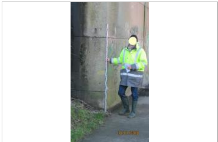
Vue du repère - Source : DREAL Grand Est/CEREMA 2018
