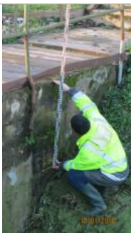
Vue du repère - Source : DREAL Grand Est/CEREMA 2018
