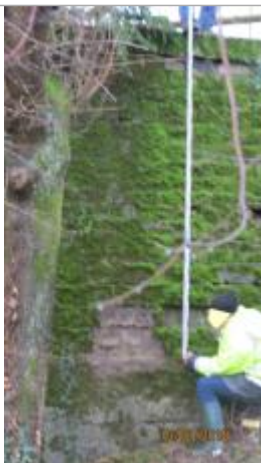
Vue du repère - Source : DREAL Grand Est/CEREMA 2018
