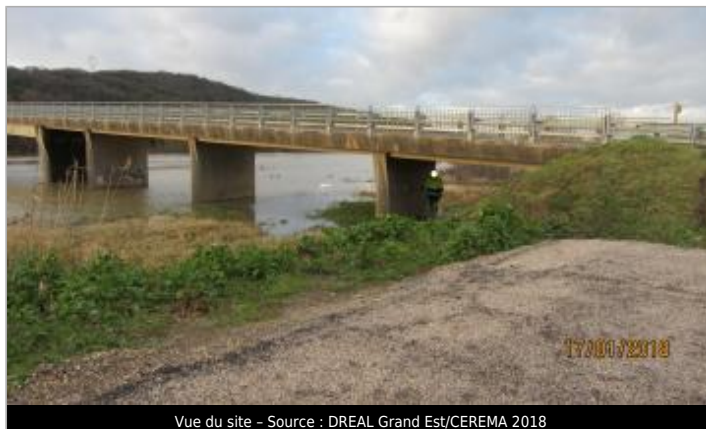
Vue du site - Source : DREAL Grand Est/CEREMA 2018
