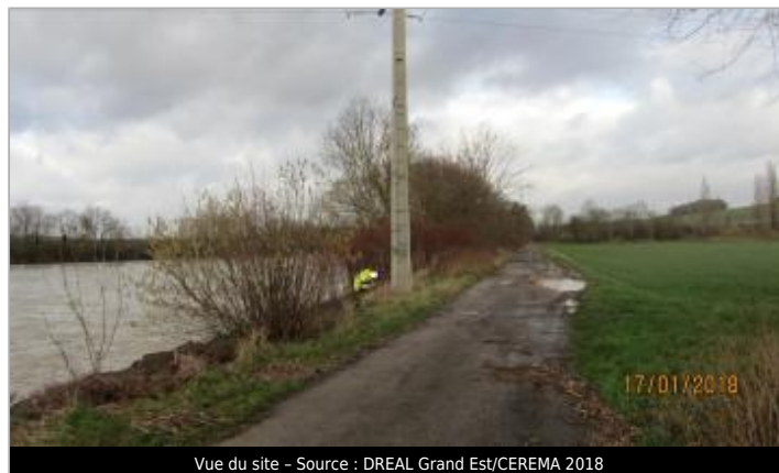
Vue du site - Source : DREAL Grand Est/CEREMA 2018
