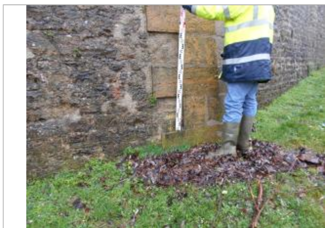
Vue du repère - Source : DREAL Grand Est/CEREMA 2018
