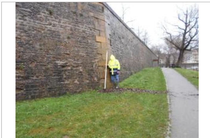
Vue du site - Source : DREAL Grand Est/CEREMA 2018
