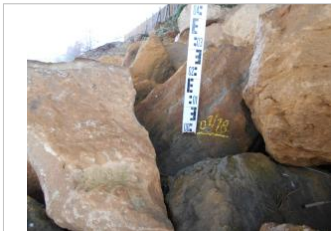
Vue du repère - Source : DREAL Grand Est/CEREMA 2018
