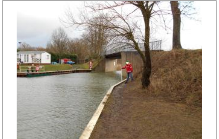
Vue du site - Source : DREAL Grand Est/CEREMA 2018
