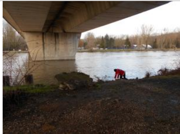
Vue du site - Source : DREAL Grand Est/CEREMA 2018
