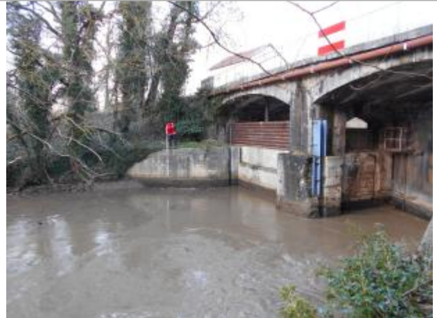
Vue du site - Source : DREAL Grand Est/CEREMA 2018
