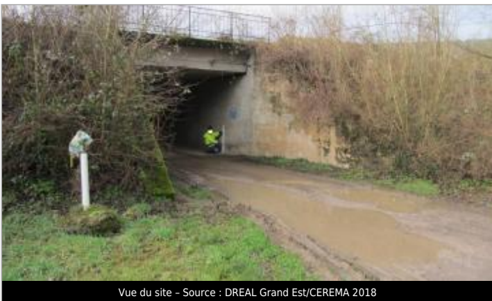
Vue du site - Source : DREAL Grand Est/CEREMA 2018
