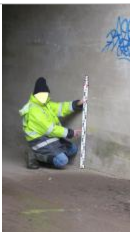
Vue du repère - Source : DREAL Grand Est/CEREMA 2018
