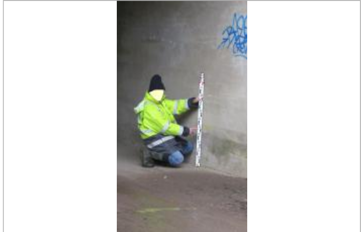
Vue du repère - Source : DREAL Grand Est/CEREMA 2018
