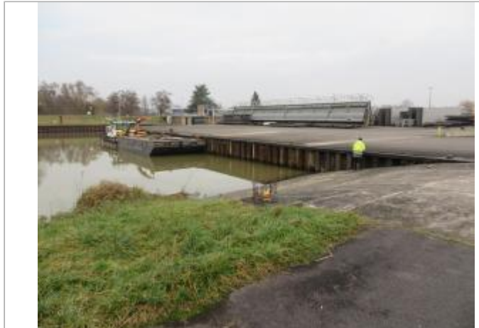
Vue du site - Source : DREAL Grand Est/CEREMA 2018
