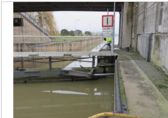
Vue du site - Source : DREAL Grand Est/CEREMA 2018
