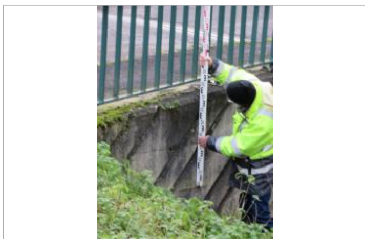
Vue du repère - Source : DREAL Grand Est/CEREMA 2018
