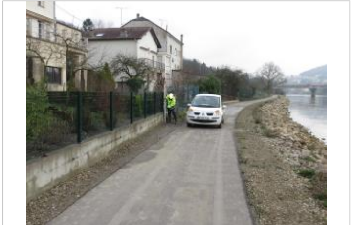
Vue du site - Source : DREAL Grand Est/CEREMA 2018
