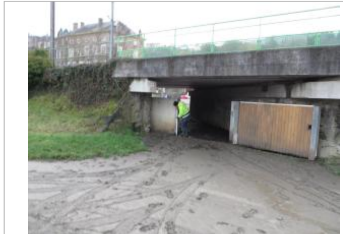
Vue du site - Source : DREAL Grand Est/CEREMA 2018
