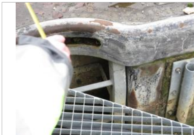
Vue du repère - Source : DREAL Grand Est/CEREMA 2018
