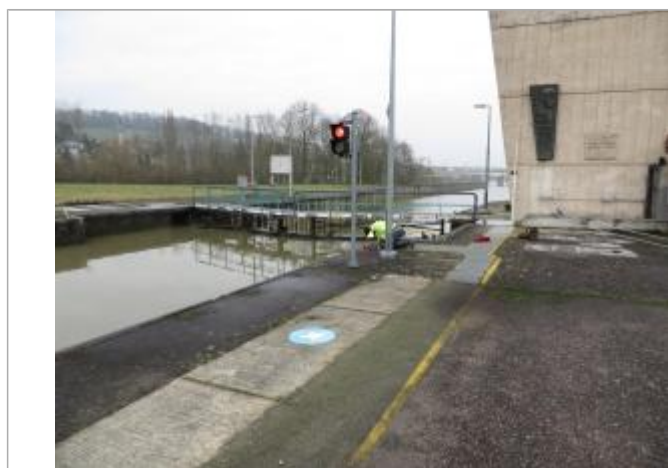
Vue du repère - Source : DREAL Grand Est/CEREMA 2018
