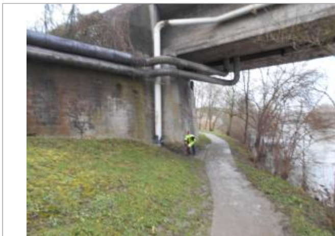
Vue du site - Source : DREAL Grand Est/CEREMA 2018
