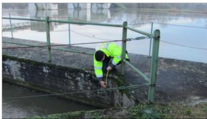
Vue du repère - Source : DREAL Grand Est/CEREMA 2018
