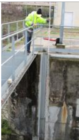
Vue du repère - Source : DREAL Grand Est/CEREMA 2018
