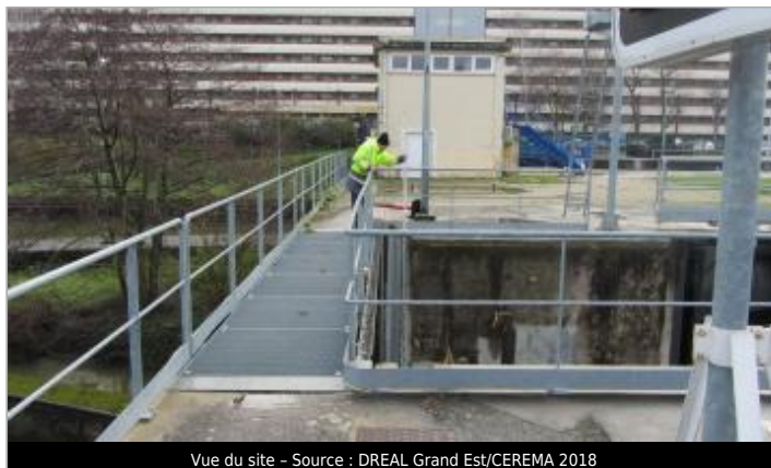
Vue du site - Source : DREAL Grand Est/CEREMA 2018
