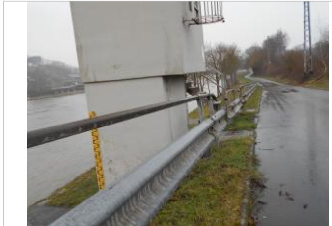
Vue du site - Source : DREAL Grand Est/CEREMA 2018
