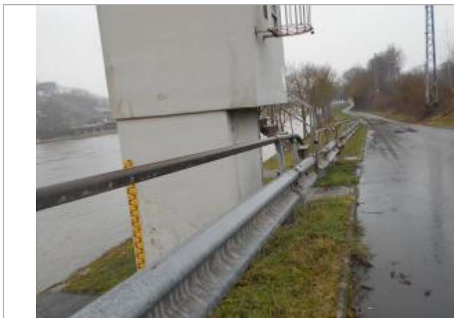
Vue du site - Source : DREAL Grand Est/CEREMA 2018
