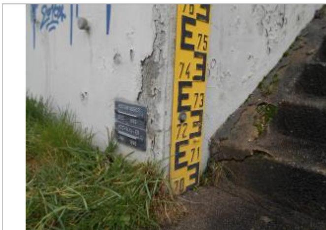
Vue du repère - Source : DREAL Grand Est/CEREMA 2018
