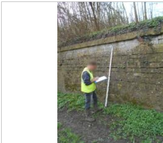
Vue du repère - Source : DREAL Grand Est/CEREMA 2018
