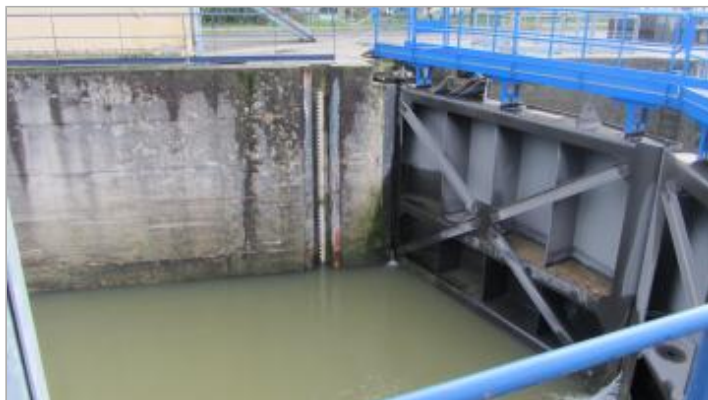
Vue du site - Source : DREAL Grand Est/CEREMA 2018
