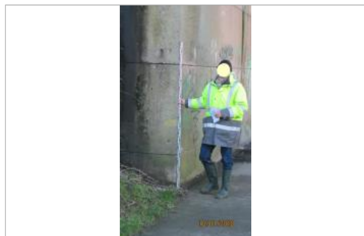
Vue du repère - Source : DREAL Grand Est/CEREMA 2018
