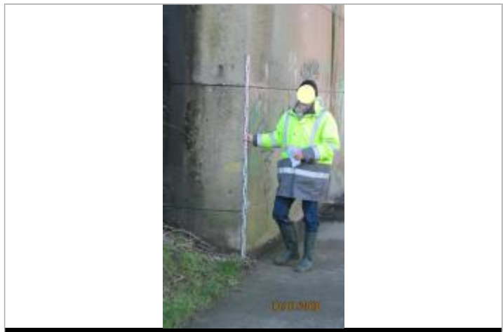
Vue du repère - Source : DREAL Grand Est/CEREMA 2018
