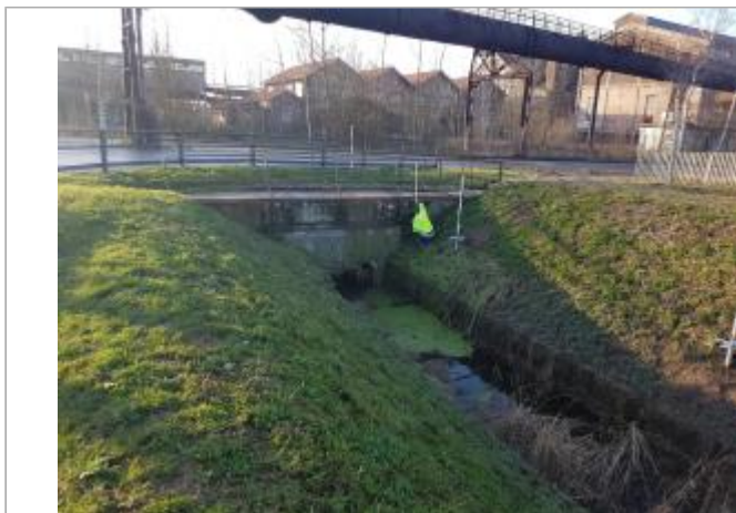
Vue du site - Source : DREAL Grand Est/CEREMA 2018
