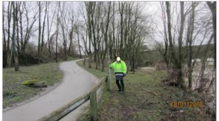
Vue du site - Source : DREAL Grand Est/CEREMA 2018
